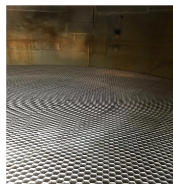
图 4 脱硫塔出口屋脊式除雾器 图 5 一二级水洗层塔式填料安装图 图 6 水洗塔出口旋流式除雾器
